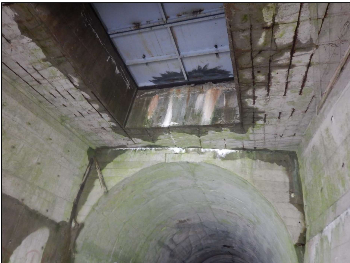
Obr. 7: Vnitřní pohled stropnice přemostění, zatékání manipulačním otvorem
