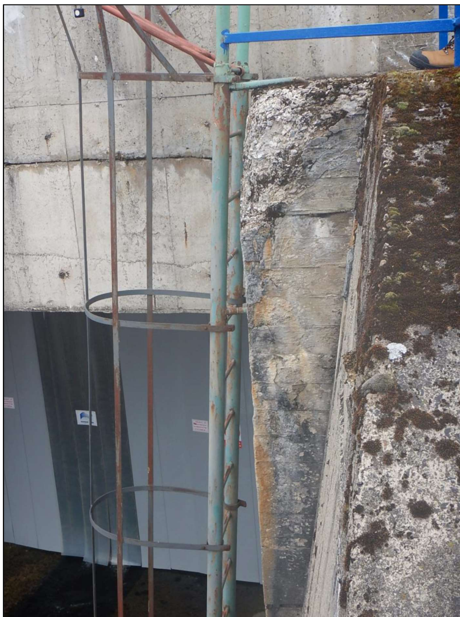
Obr. 6: Degradované povrchy stěn, hran, poškozené kotvení žebříku
