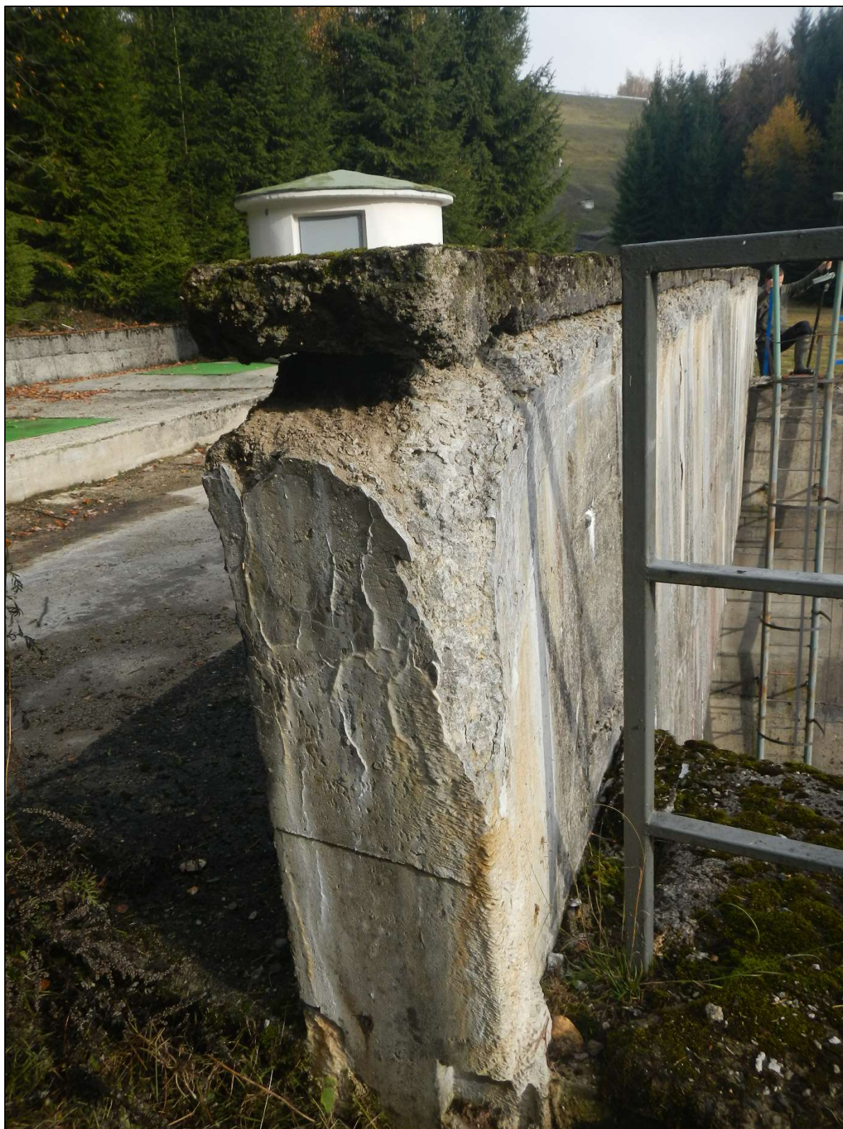
Obr. 8: Destruovaná parapetní zídka
