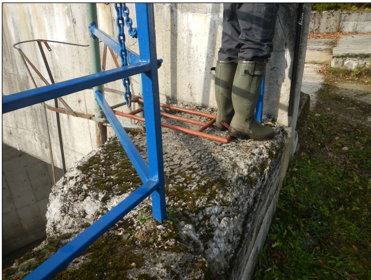
Obr. 5: Degradované povrchy stěn, hran, poškozené kotvení žebříku
